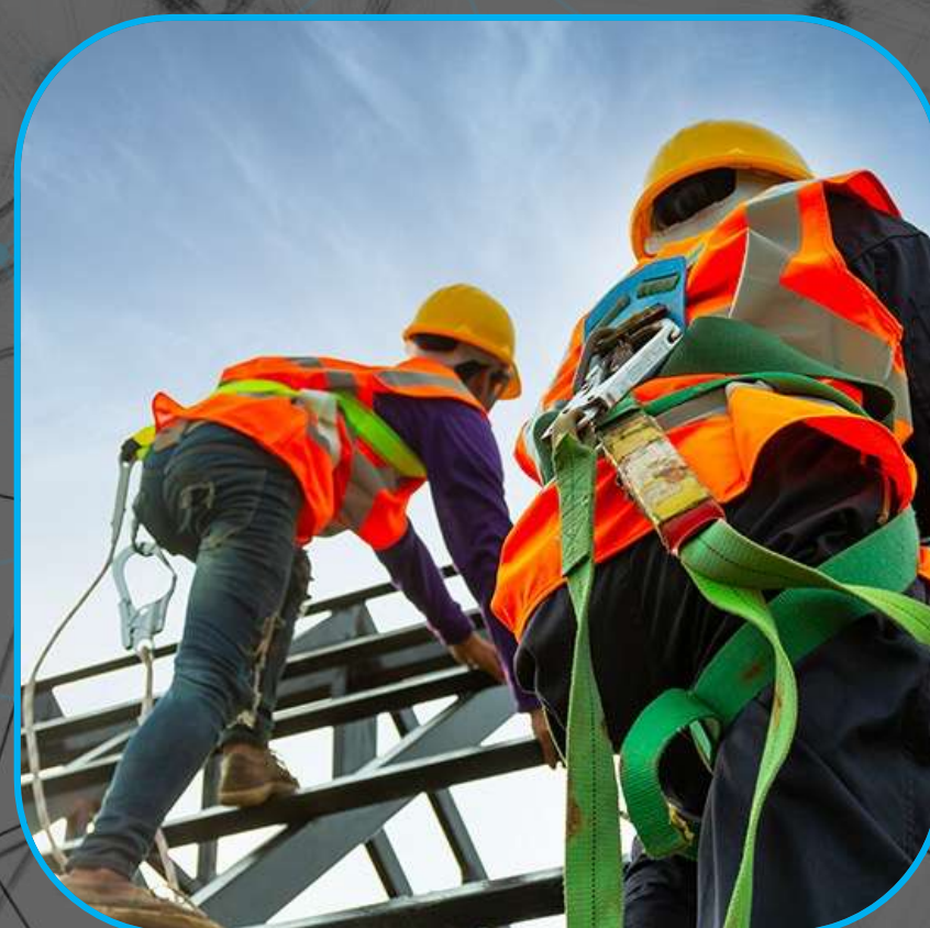
Lavori in quota
